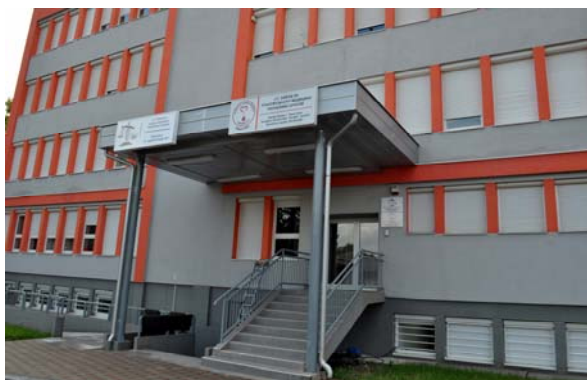
Zgrada Zavoda za sudsku medicinu nakon rekonstrukcije
